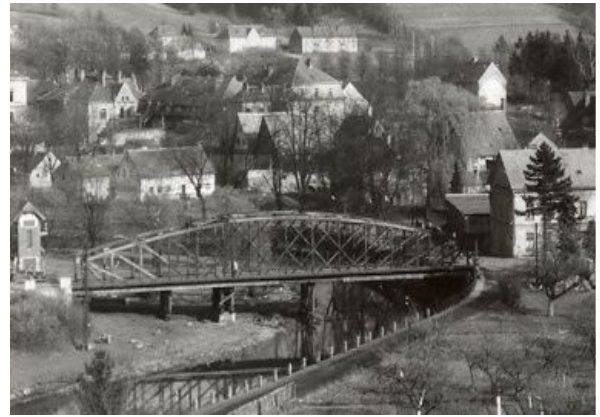
Queisbrücke 04.1957 noch mit zusätzlichen Holzstützen fot. A.Hanke © Bildarchiv Beckert
