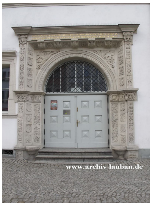
Eingang des Muzeum in Luban im alten Rathaus nach Restaurierung. © Beckert
